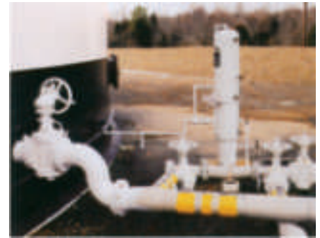
L'isolation côté réservoir maintient l'intégrité du produit
